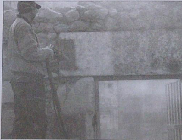
Foto 9 Mikro-kumlama yöntemi ile temizlik yapılırken (Milet İlyas bey Medresesi)
